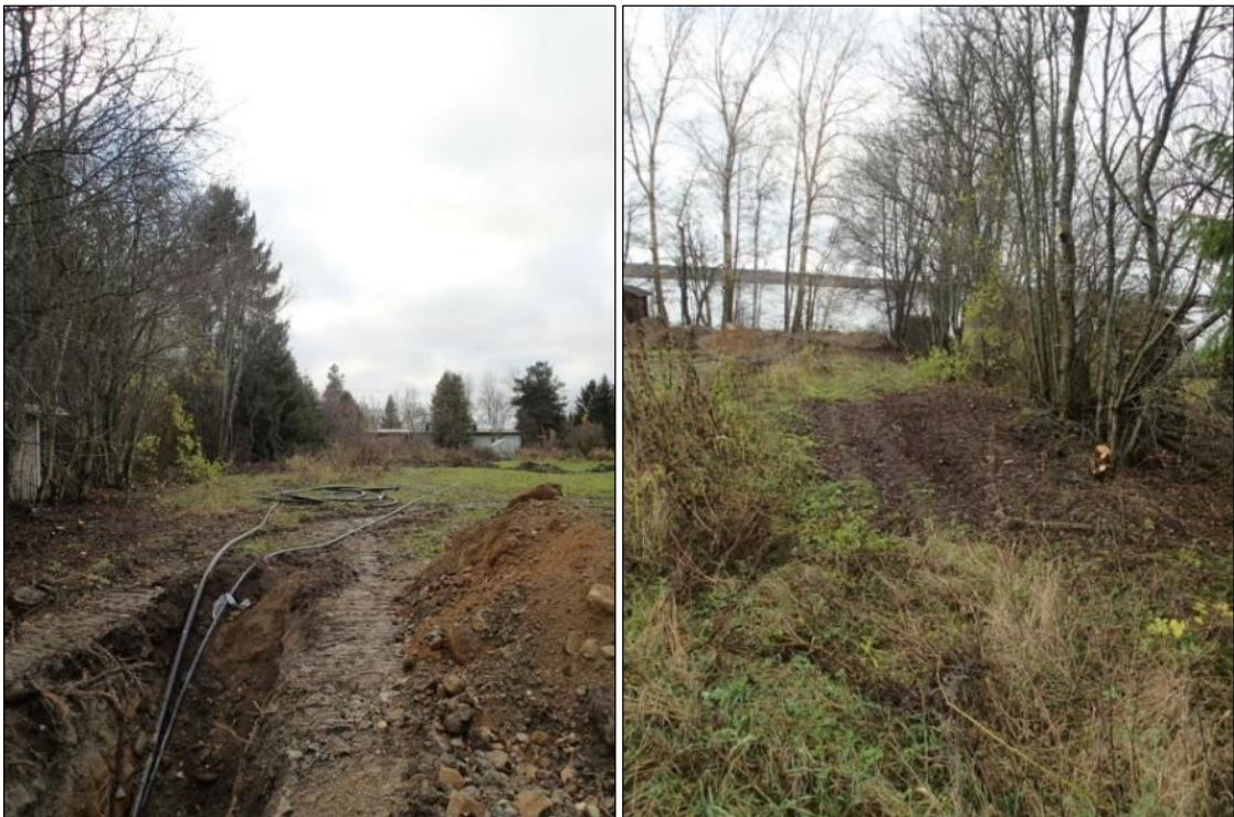
Vasen kuva: Vesihuoltolinjan reittiä pellolla puustoon oikealla puolella ennen kaivamista. Kuvattu kaakkoon. Oikea kuva: Vesihuoltolinjan reitti puustoon vasemmalla laidalla. kuvattuna pohjoiseen
