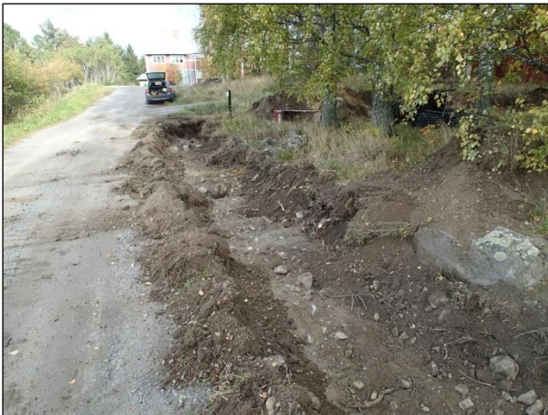
Vasen kuva: Maantien pohjustamiskerrosta vesihuoltolinjalla Nokkakyläntien varressa. Pohjoiseen. Oikea kuva: Sekoittunutta kerrosta moreeniin saakka Torranniementien varressa. Länteen.
