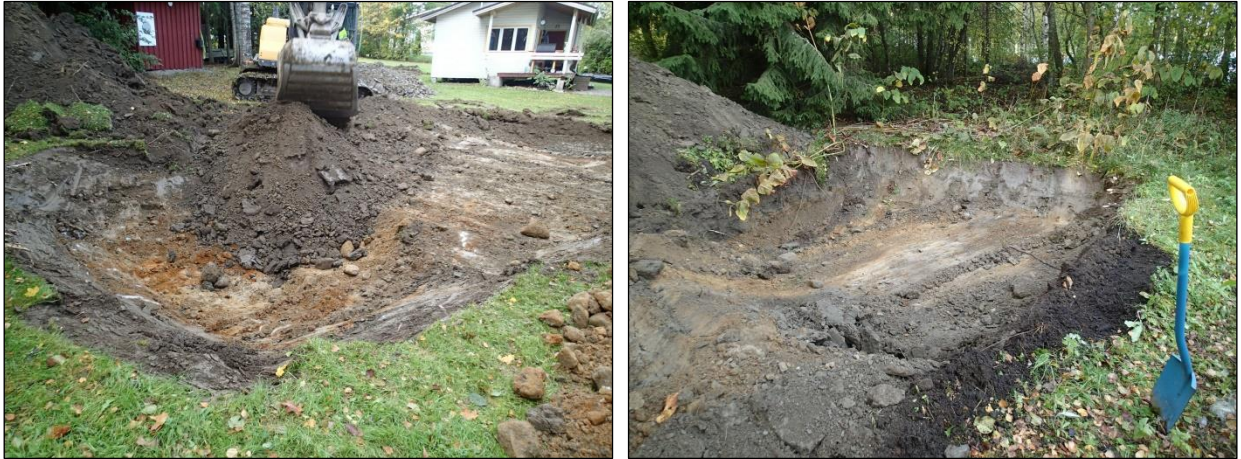
Vasen kuva: Porauskuoppa 1. Kuvattu länteen. Oikea kuva: Porauskuoppa 2. Kuvattu luoteeseen.
